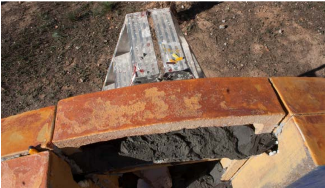
Figura 20: Relleno mortero
