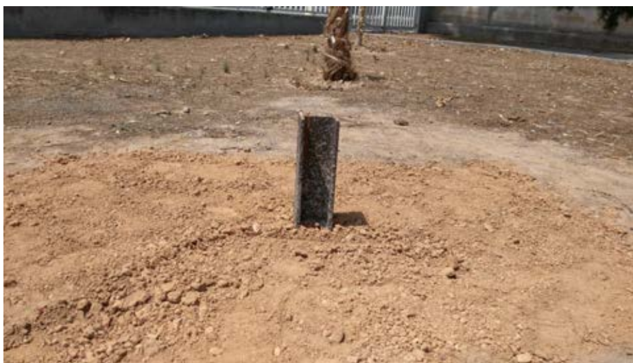
Figura 14: Pilar de HEB de 100, de 35cm
